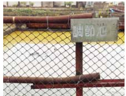
◎調節池。可容納數天量的廢水，可使廢水濃度趨於穩定，利於往後之處理，又廢水中如缺乏氮、磷、鉀等要素亦可在調節池中調整養份，以利微生物之生長。
