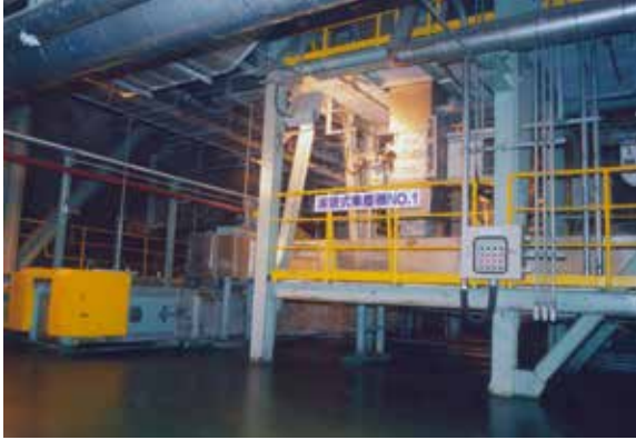
◎岡山垃圾焚化廠-KS28濾袋式集塵器底部及飛灰輸送機
