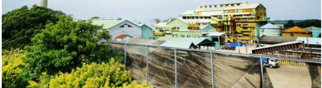
◎調節池。可容納數天量的廢水，可使廢水濃度趨於穩定，利於往後之處理，又廢水中如缺乏氮、磷、鉀等要素亦可在調節池中調整養份，以利微生物之生長。
