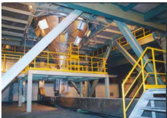
◎岡山垃圾焚化廠-KS26半乾式洗煙塔底部
