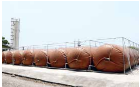
沼渣沼液肥份與水資源循環再利用
