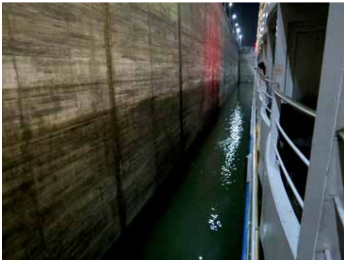
圖2：郵輪「爬樓梯」進入三峽大壩，船外就是一片水泥牆
