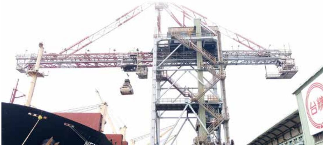
◎使用抓斗進行卸船作業中的卸糖機
