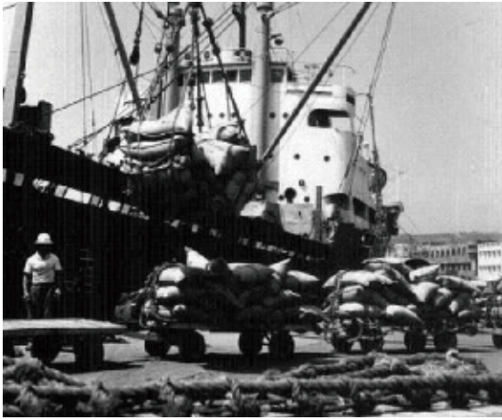
◎早期的人力裝卸船作業模式
