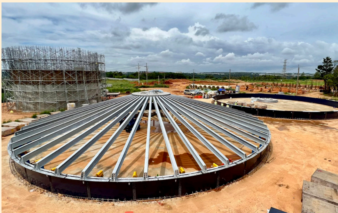
農業循環豬場改建施工實景
