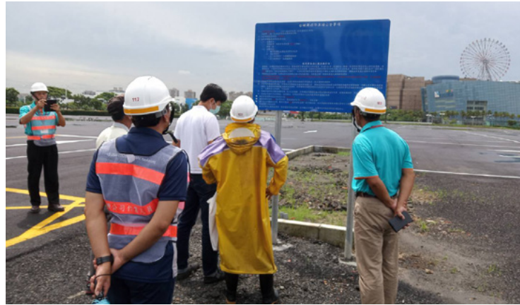
主管機關人員勘查停車場現場情景
