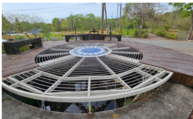
二峰圳的分水工。水閘門以控制分水流量，並把水分送各輸水支線，由各支線圳道運抵灌溉農田
