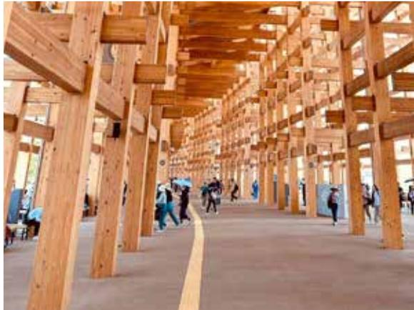
由建築師藤本壯介設計的「大屋根」，以 109 個木構單元環形組構而成，已獲金氏世界紀錄成為全球最大的木造結構體
