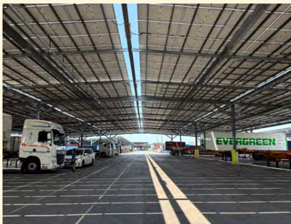
台糖中安停車場結合光電設置的未來想像（圖為台糖中厝停車場）。
