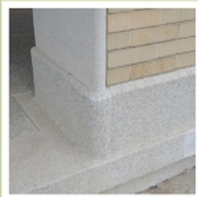
中棟、南棟拱廊柱基座 及地坪收邊
