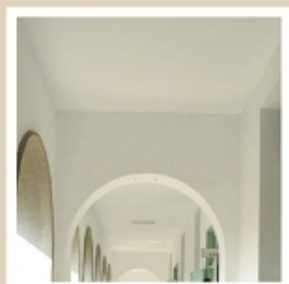
中棟南棟外廊 牆面上部、天花
