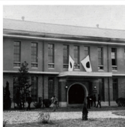
原北棟本部廳舍屋頂通風塔
