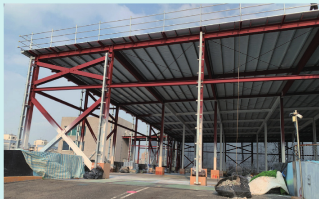
園區南北棟 6 樓停車場倉庫 (改建前)
