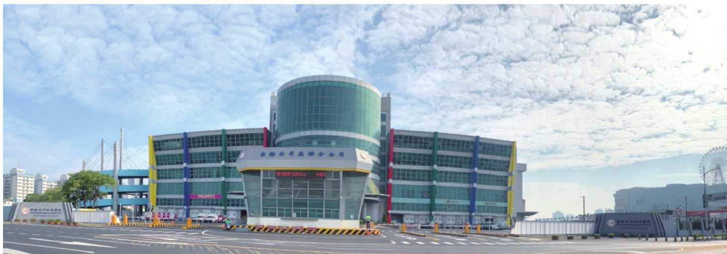
園區大門改建工程
