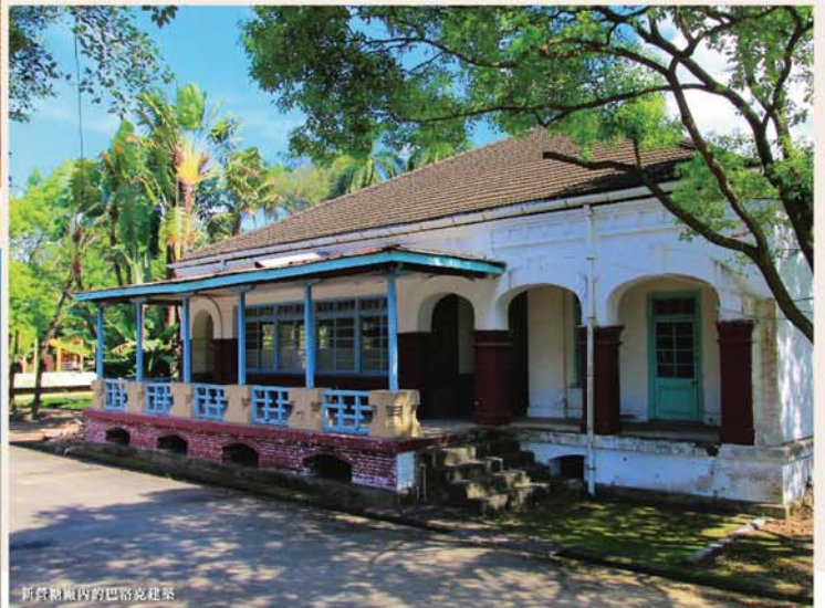
新營糖廠內的巴洛克建築
