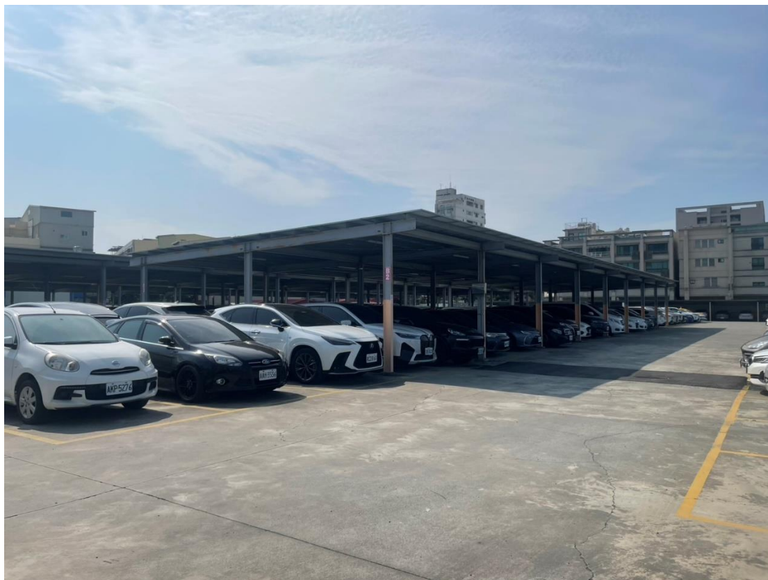
高雄市小港區港墘段 3-8 地號等 4 筆之現況照片
